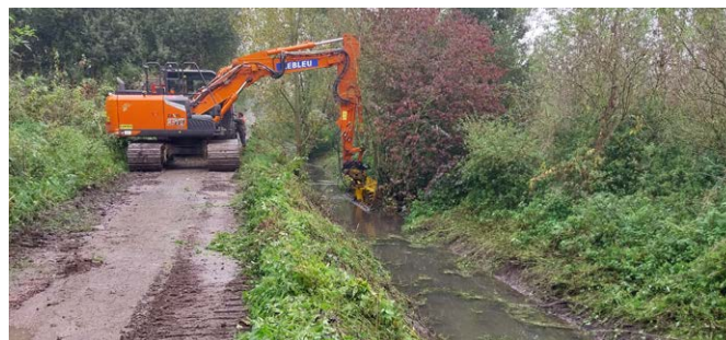
Réalisation du faucardement (fauchage de végétaux aquatiques) du Riez-Simon par les prestataires de la MEL.
